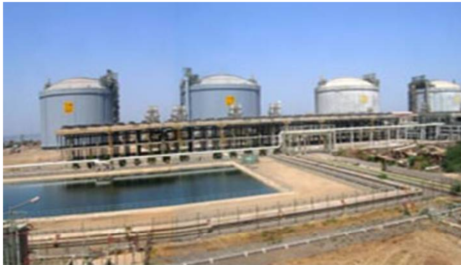
Fig 2.10 LNG Storage Tanks at PLL Plant (www.petronetlng.com)
